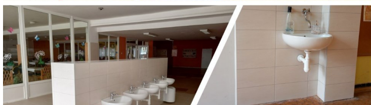
Rekonštrukčné práce v škole 2022
